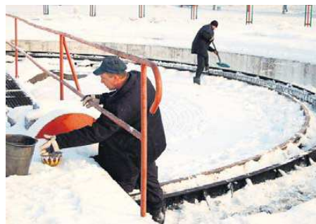
Przy takich opadach obrotnicę trzeba często oczyszczać
